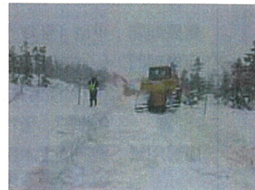
開通前の除雪作業
