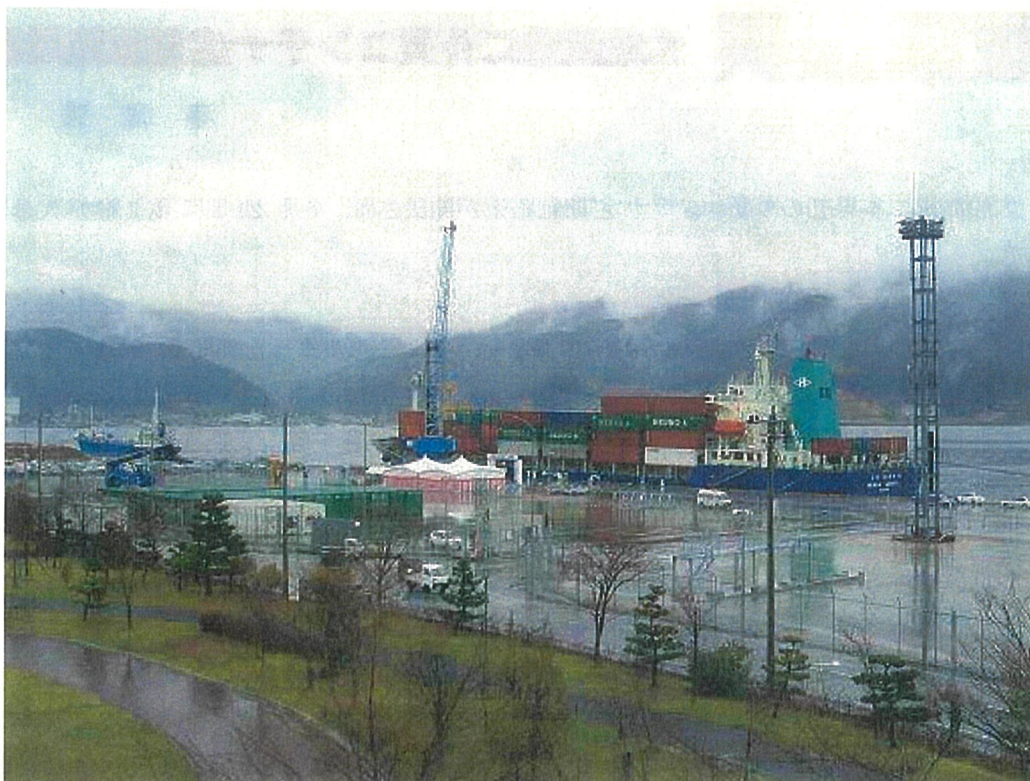
コンテナ船とターミナル全景
