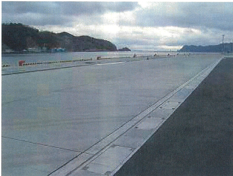
新たに整備された水深 11m の岸壁
