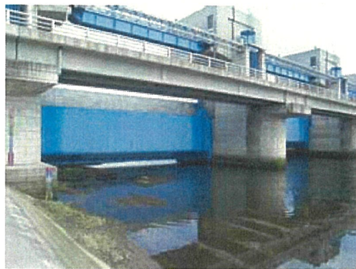
ゲートの降下状況
