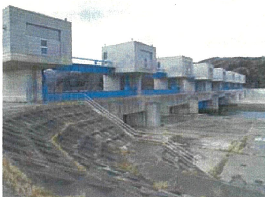
右岸下流側より水門を望む
