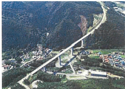
今回開通区間で最長の橋 [洞泉橋 L=405m]
