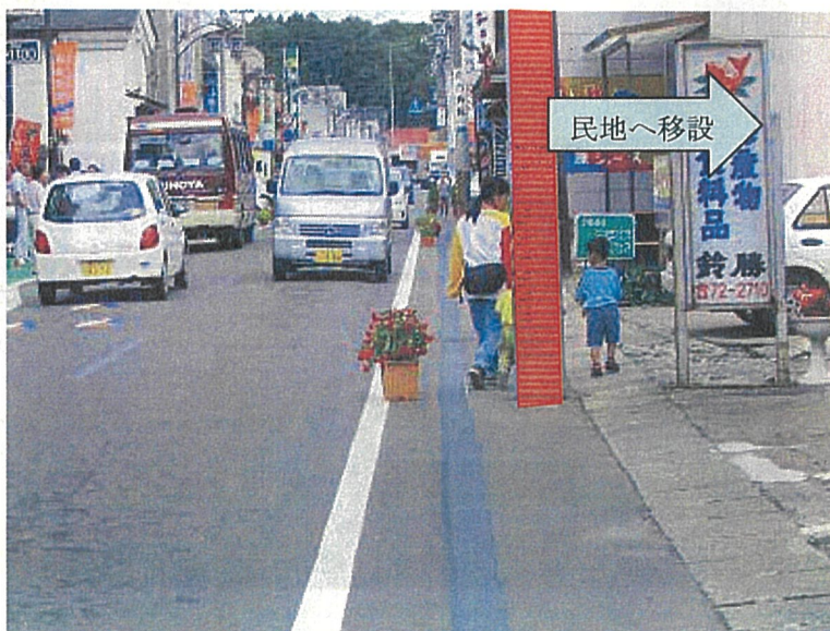
電柱が歩行者の通行障害となっている様子
