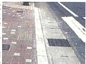
国道284号 段差解消 (一関市大町地区)
