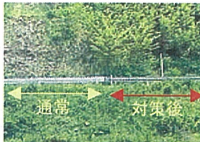
一般県道 折壁大原線 景観に配慮したガードレール (一関市千厩町)
