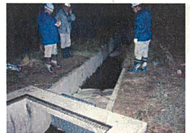
過去に発生した油流出事故の状況
