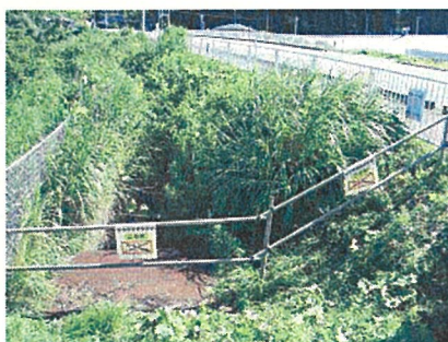
防護柵（応急）を設置した集水枡
