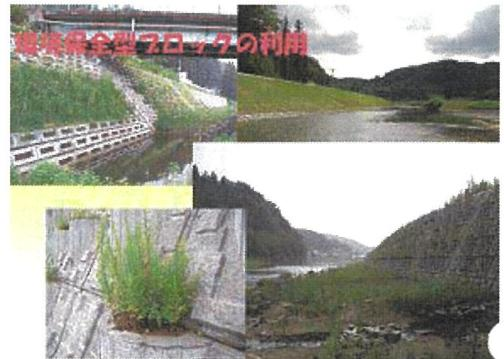
写真②は、街中の箇所で、先ほど説明したとおり川幅が上下流に比べて狭いため、護岸勾配を5分としています。また、ブロックの直高が5mを超えるため「環境保全型大型ブロック積工」としています。仕上げで水際部に置石を配置して水際線が单调とならないように配慮しています。
