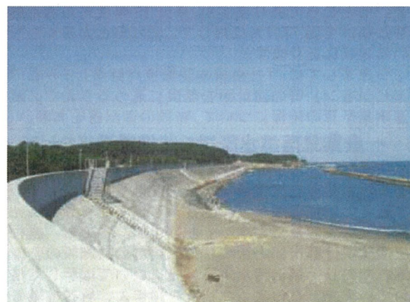
平内海岸 防潮堤整備中
