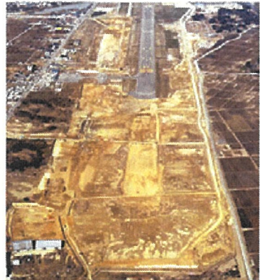
昭和56年 1,200mで暫定共用中の2,000m滑走路工事
