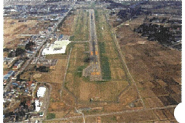
平成9年 滑走路2,500m整備事業着手前の2,000m滑走路
