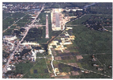
昭和55年 1,200mの滑走路と建設中の2,000m滑走路
