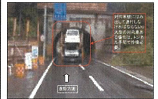
国道283号(釜石市大橋)
