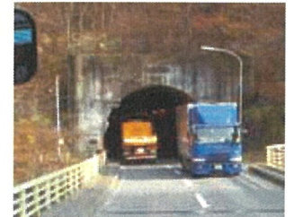
国道281号(久慈市鰻淵トンネル)
