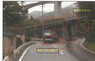
国道283号(釜石市洞泉)
