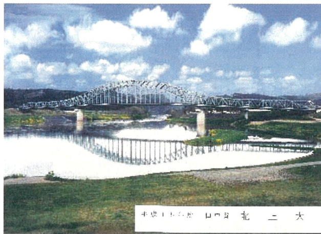
次世代にその優美な姿を引き継ぐ北上大橋の全景
