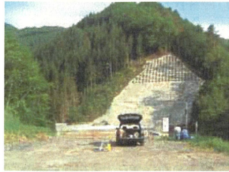
国施工の滝観洞トンネル方面を望む
