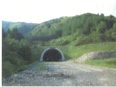
県施工の秋丸トンネル
