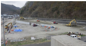
太田名部漁港 臨港道路の整備
