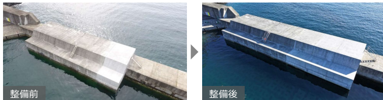
(両石漁港) 防波堤
