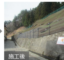
急傾斜地崩壊防止施設（急傾斜地崩壊対策事業）
