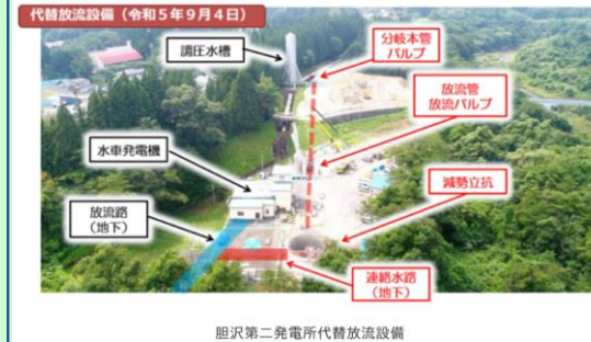
胆沢第二発電所代替放流設備
