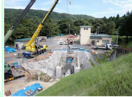
胆沢第二発電所代替放流設備（放流バルブ設置状況）
