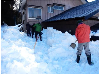
宅地周りの除雪作業
