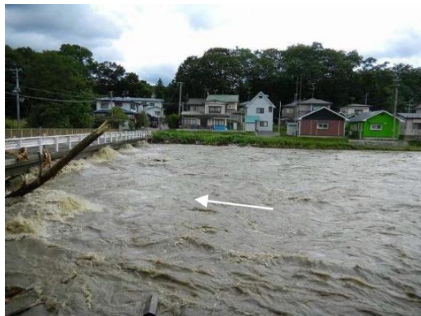
馬淵川 関谷工区(岩根橋上流)の状況
