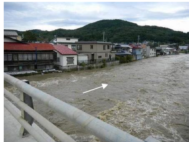
馬淵川 本町工区(斗米橋上流)状況
