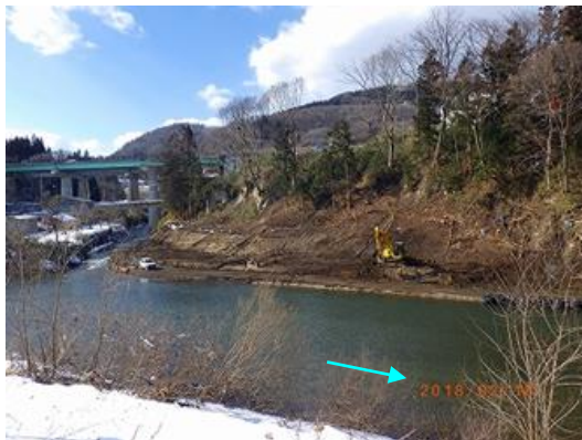
馬淵川堀野工区 掘削工事の状況
