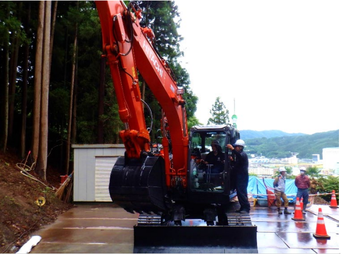
ICT重機の乗車体験
