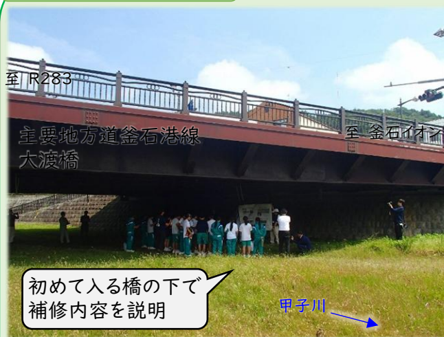
現場見学（大渡橋）
