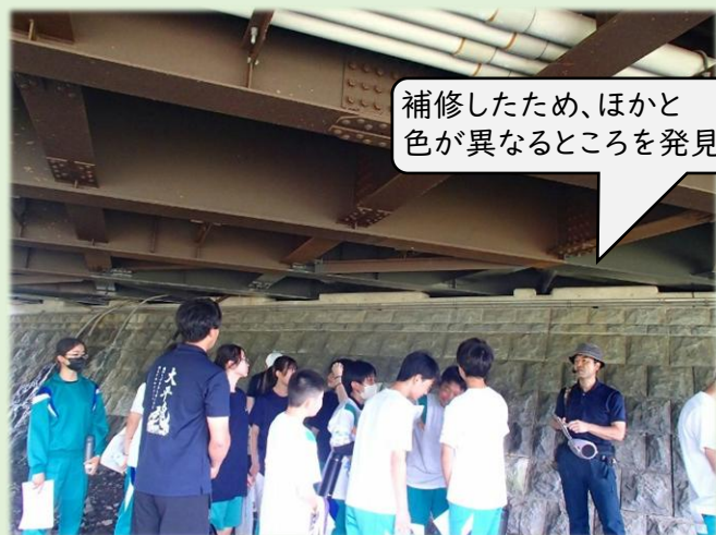
補修箇所見学
