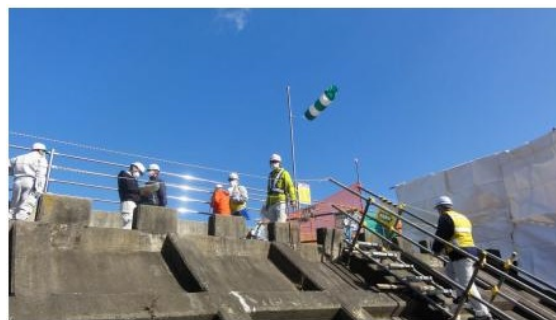
工事安全パトロールの状況
