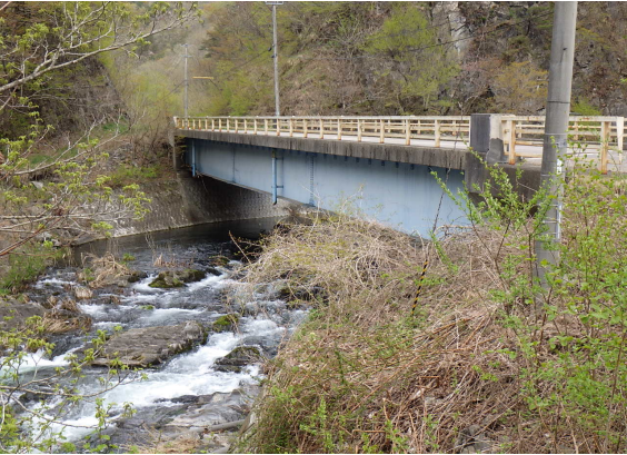
橋梁補修 主要地方道久慈岩泉線天狗橋【左】着工前 【右】桁塗装補修後（R6 完成）
