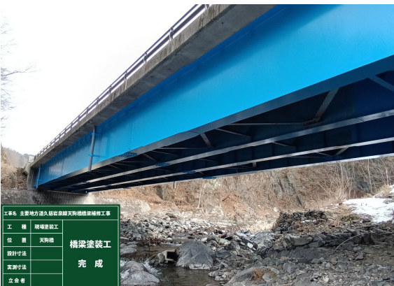
橋梁補修 主要地方道久慈岩泉線天狗橋【左】着工前 【右】桁塗装補修後（R6 完成）
