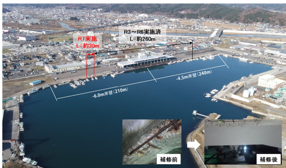
久慈港諏訪下地区 岸壁補修
