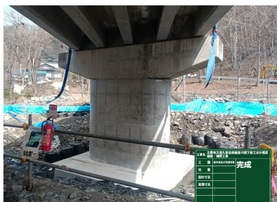
(橋梁耐震補強) 主要地方道久慈岩泉線遠川橋 【左】着工前 【右】巻き立て補強後 (R7 完成予定)
