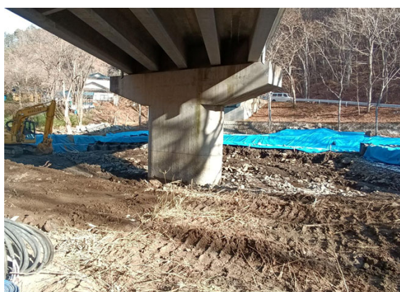
(橋梁耐震補強) 主要地方道久慈岩泉線遠川橋 【左】着工前 【右】巻き立て補強後 (R7 完成予定)
