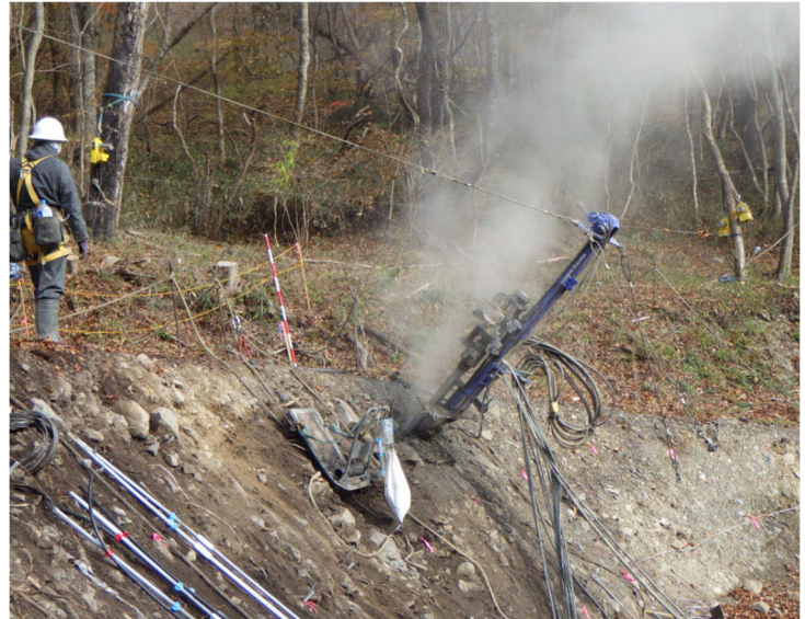
▼鉄筋挿入工の施工状況
