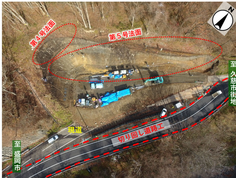
▼航空写真（法面工の現況）
