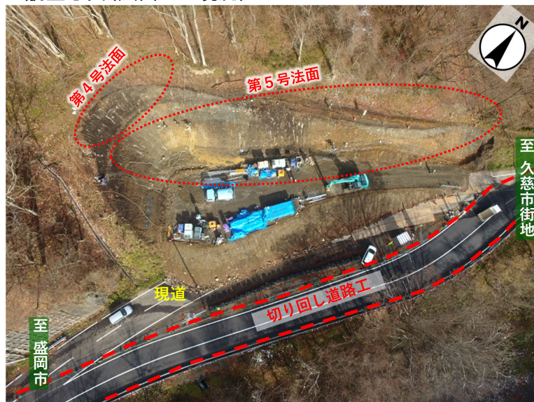
▼航空写真(法面工の現況)
