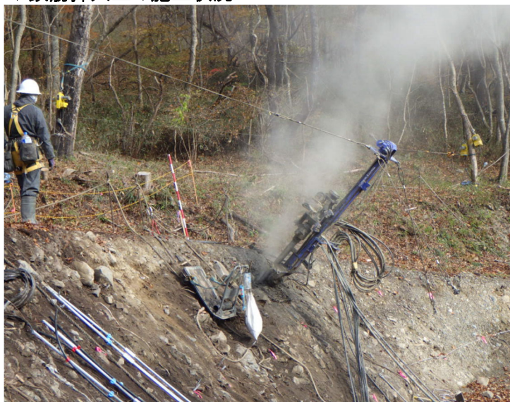
▼鉄筋挿入工の施工状況
