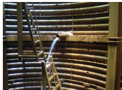
集水井の内部(地下水の排水状況)
