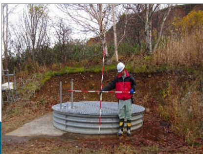
集水井の外観
