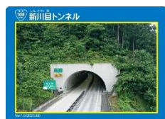
⑤新川目トンネル
