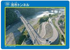
①茂市トンネル
