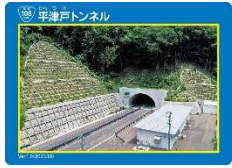
⑤平津戸トンネル
