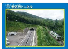
①新区界トンネル
