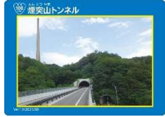
①煙突山トンネル
