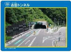
③古田トンネル
