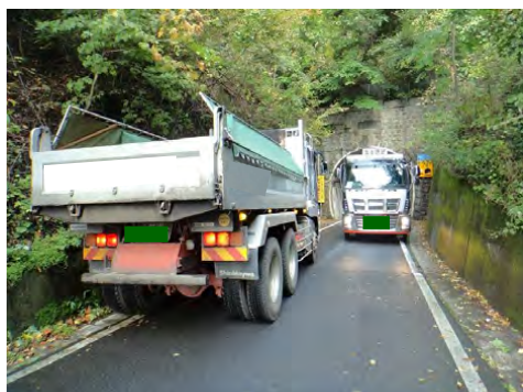
旧国道340号 雄鹿戸トンネル (岩泉側坑口)
