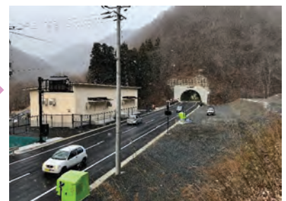
押角トンネル(宮古側坑口)
