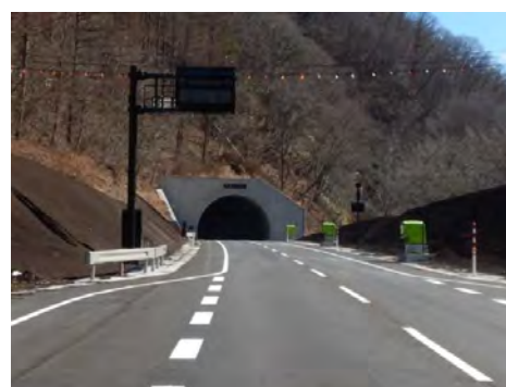
新国道340号 押角トンネル (岩泉側坑口)
