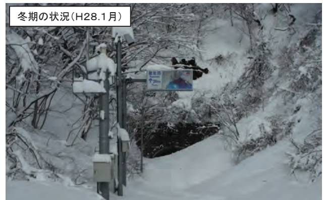
雪崩による通行止め
