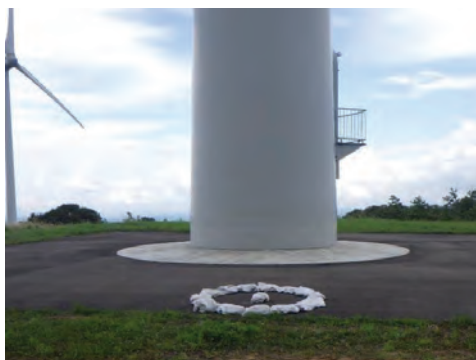
バードストライク対策状況
