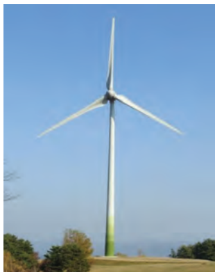
6号風車のみ タワー基部を 緑色に塗装
