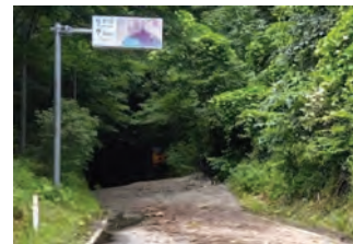
旧国道340号 雄鹿戸トンネル(宮古側坑口)
