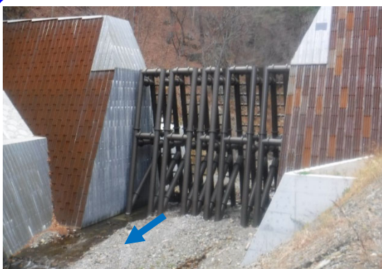
土石流発生前(R4年11月撮影)
