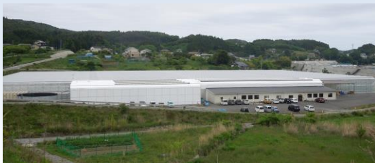
整備された高度環境制御型園芸ハウス
