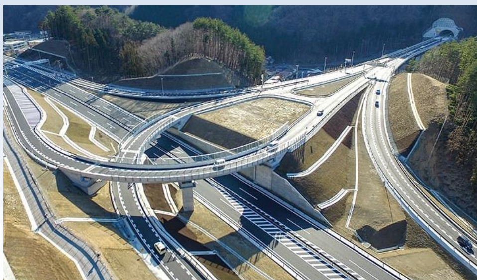
三陸沿岸道路・東北横断自動車道釜石秋田線 結節部 釜石 JCT
