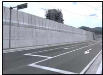
令和5年度に完成した 普金地区海岸防潮堤（大船渡市）
