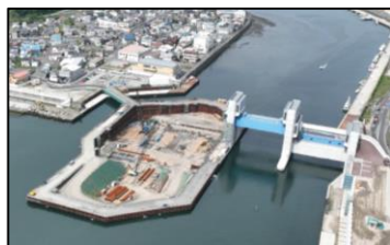
整備中の開伊川水門（宮古市）
