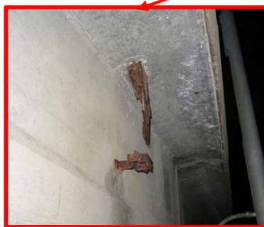
橋面部の雨水等を排水する排水管の腐食
