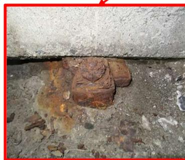
荷重を上部工から下部工に伝える支承部の腐食
