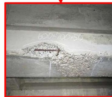
橋の荷重を支えるコンクリート主桁の欠損
