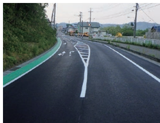
令和5年度優良県営建設工事 一般県道二戸軽米線長嶺地区舗装補修工事
