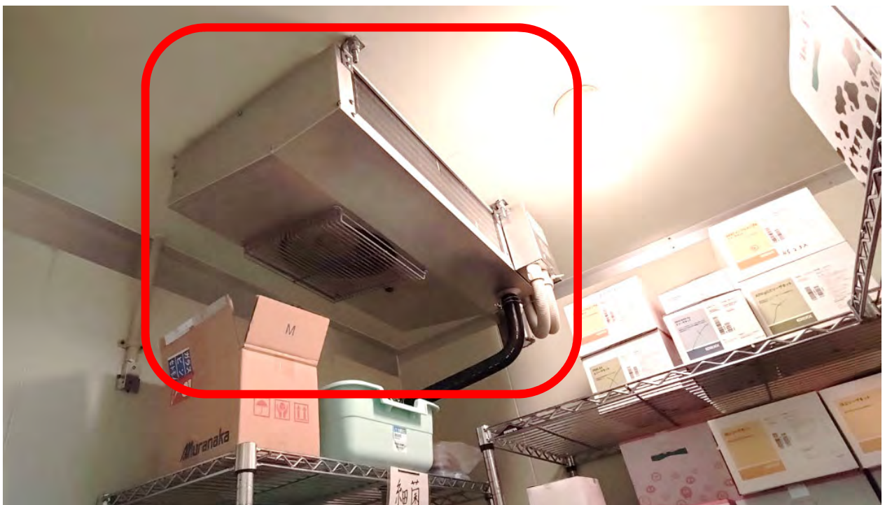
⑤ 交換修繕部分（本体・拡大）
