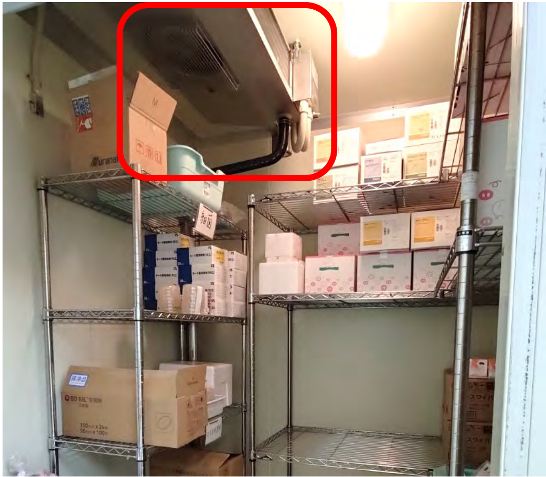
④ 交換修繕部分（本体）
