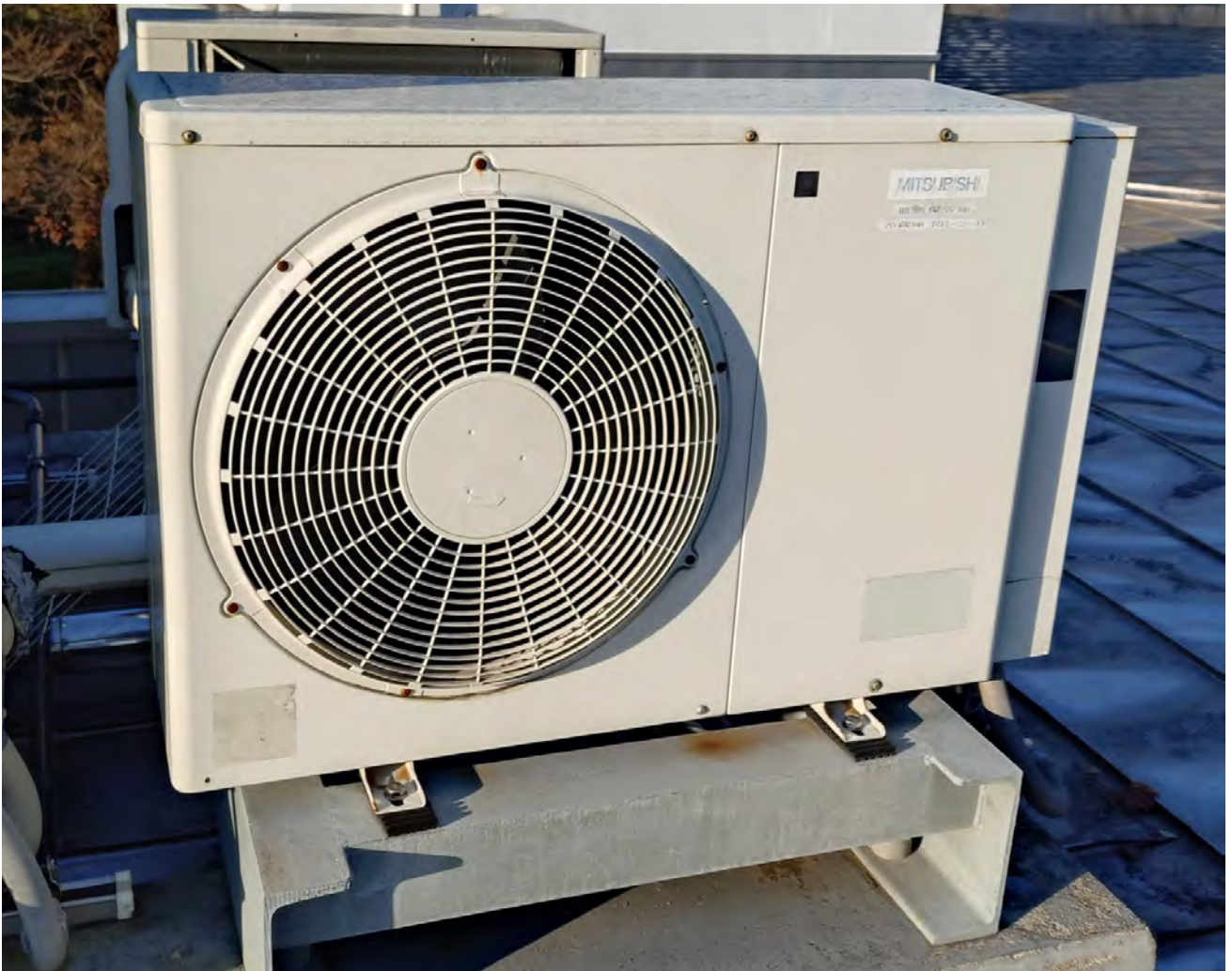
⑦ 交換修繕部分（室外機・拡大）
