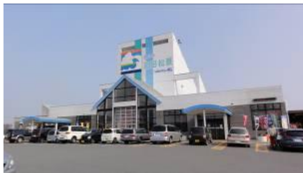
写真4 震災以前の道の駅「高田松原」
