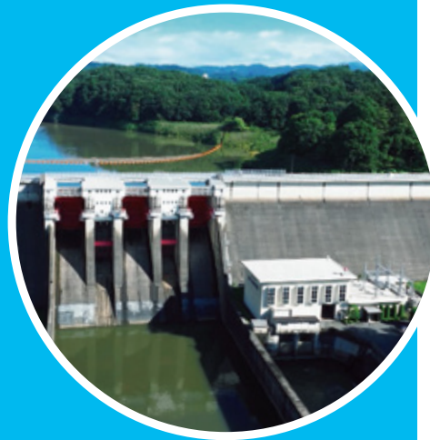
岩手県企業局 四十四田発電所
