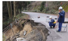
危険箇所での被災状況調査
