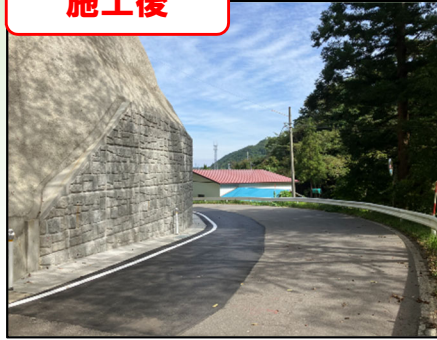
整備状況写真①
