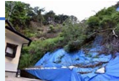
豪雨の度に 土砂崩れが多発
