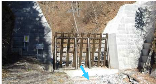
土石流発生前(R5年11月撮影)
