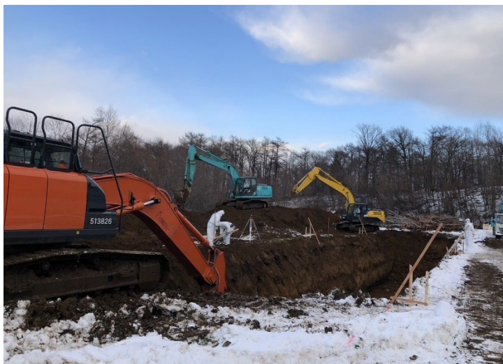
埋却地での掘削作業
