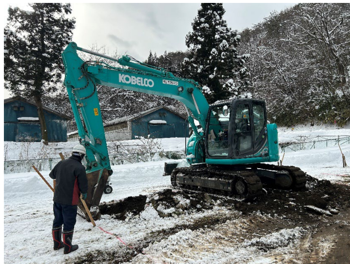
埋却地での掘削作業
