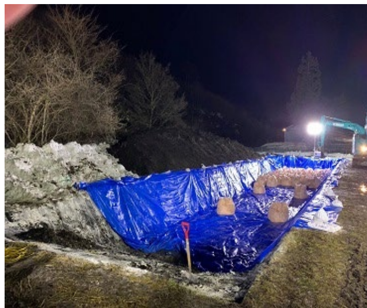
処分鶏等の埋却作業
