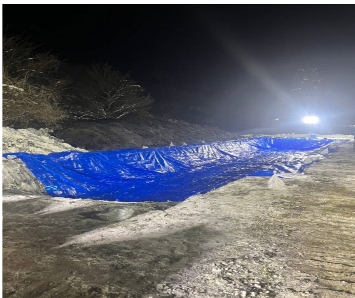
埋却溝へのブルーシート敷設
