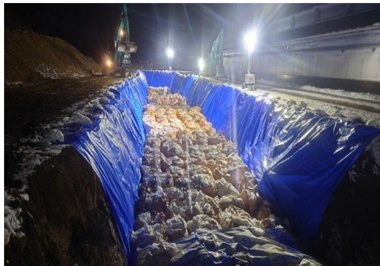
処分鶏等の埋却作業
