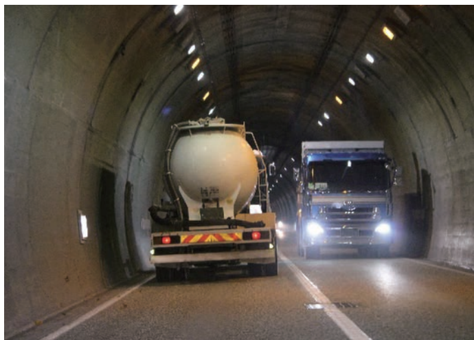
トンネル内での大型車のすれ違い。幅員が狭く余裕がない。
