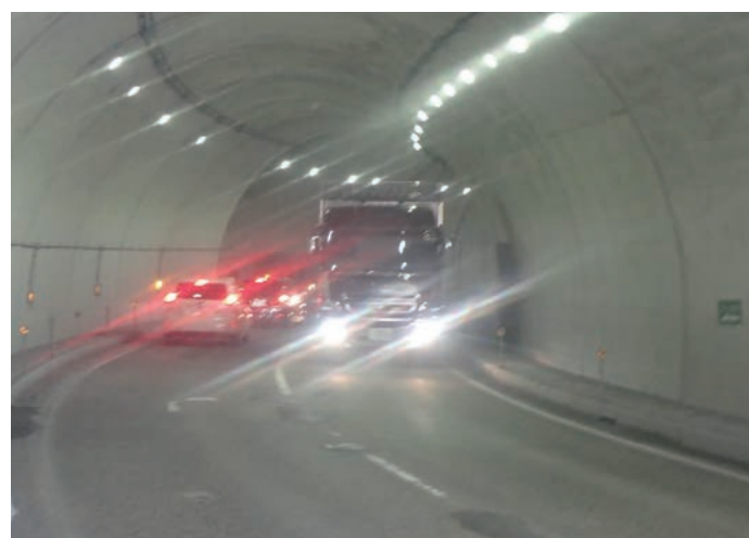
住田町側トンネル出口付近。すれ違い時の減速状況。
