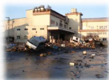
久慈港諏訪下地区被災状況
