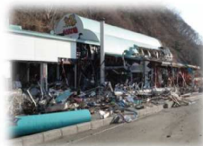
もぐらびあ被災状況
