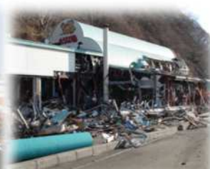
もぐらんぴあ被災状況
