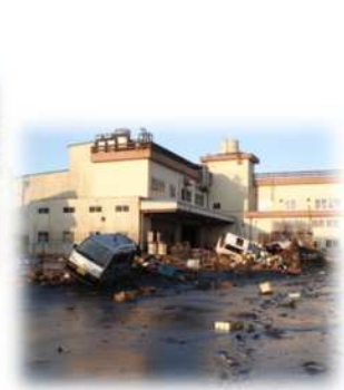
久慈港諏訪下地区被災状況
