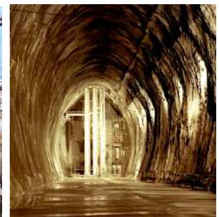
地下岩盤タンク
