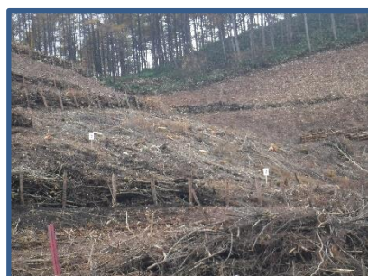
地拵え後の状況
