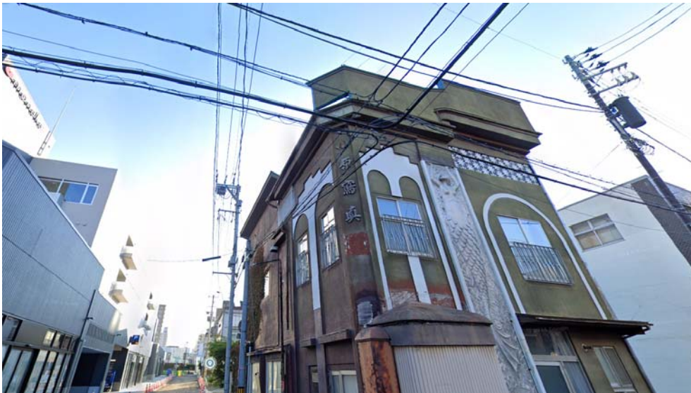
現況写真 (D方向より)
