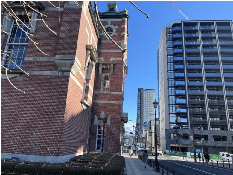
現況写真 (B方向より)
