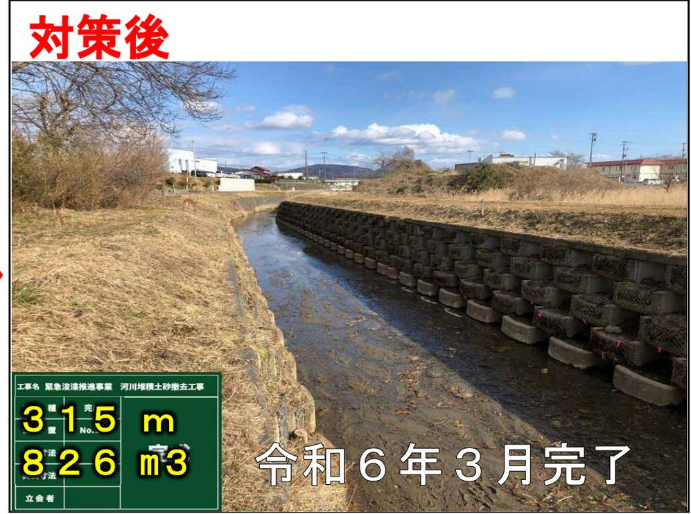
**対策の内容** 河川に堆積した土砂等の撤去を行い、河川の流下能力を確保したことで、洪水被害が発生するリスクを低減しました。
