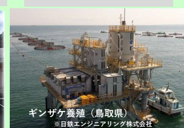
ギンザケ養殖(鳥取県) ※日鉄エンジニアリング株式会社 大型浮沈式生簀や遠隔自動給餌システムによる省力化・生産性の向上
