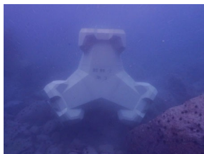
ブロックの設置
