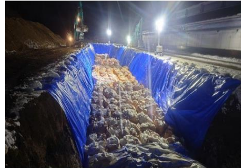
処分鶏等の埋却作業
